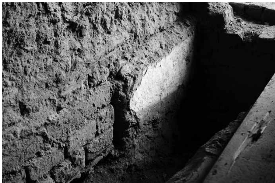
Obr. 4. Původní hliněná interiérová omítka s modrou podrovnávkou odkrytá při rekonstrukci objektu. Dobruška, čp. 5 (okr. Přerov). Foto M. Novotný, 2011.
