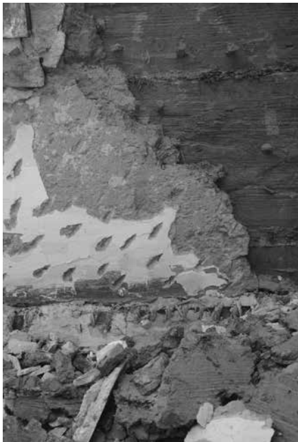
Obr. 5. Modrá obrovnávka v interiéru s detailem původní hliněné omítky („kožichu“) na dřevěném srubu. Přerov-Dluhonice čp. 10. Foto M. Novotný, 2012.
