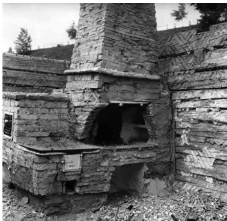
Obr. 3. Šturalova pasekářská usedlost během demontáže – pec a sporák. VMP Rožnov, inv. č. N 15 452. Foto L. Holčák, 1969.
