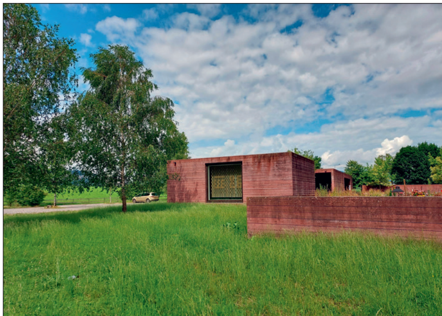
Obr. 3 Budova modlitebny s velkým oknem. Autor: Martin Klapetek, 2023.
