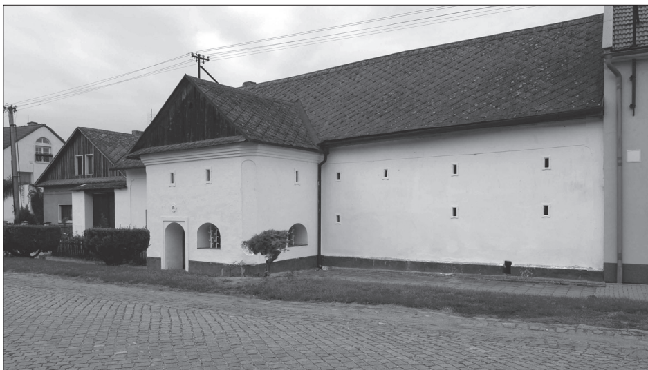
Obr. 1. Příkazy. Statek čp. 26 (vlevo bývalá výměnkářská chalupa). Foto J. Škabrada; 2013.
