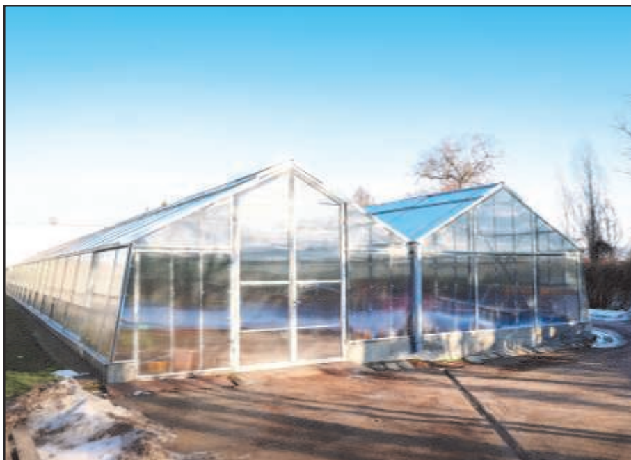
Celková rekonstrukce dvoulodního skleníku LUR 245. (sj)
