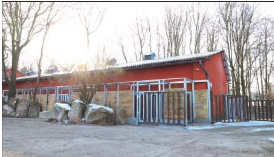
Generální oprava a úprava pavilonu nosorožců 3. (sj)
