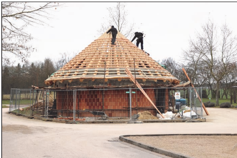
Stavba nového sociálního zařízení v Safarikempu. (sj)
