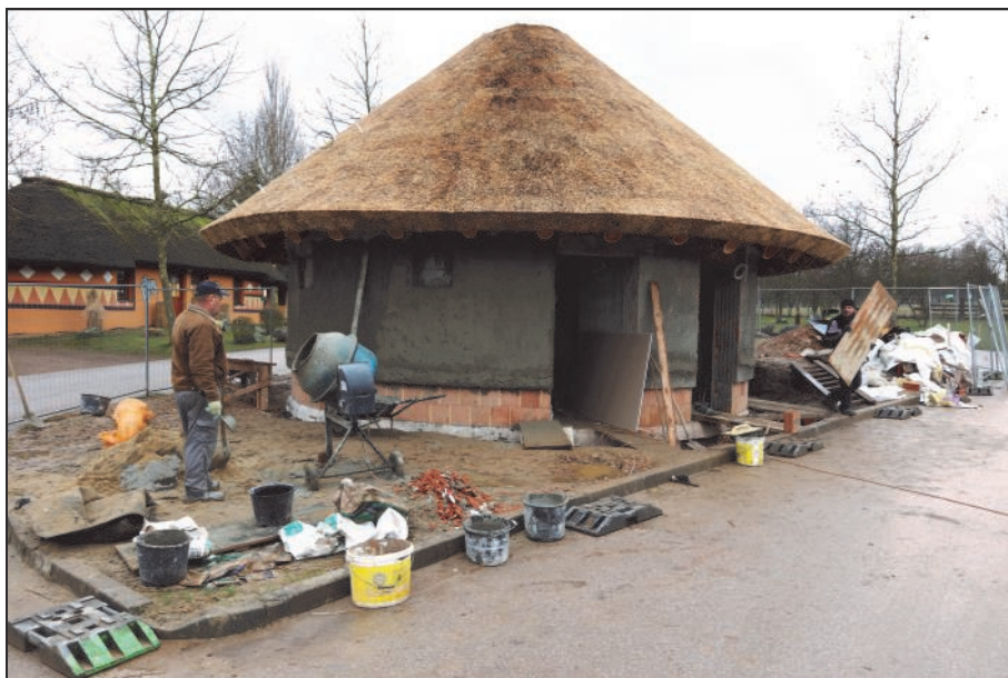
Rekonstrukce sociálního zařízení v Safari kempu. (sj)
