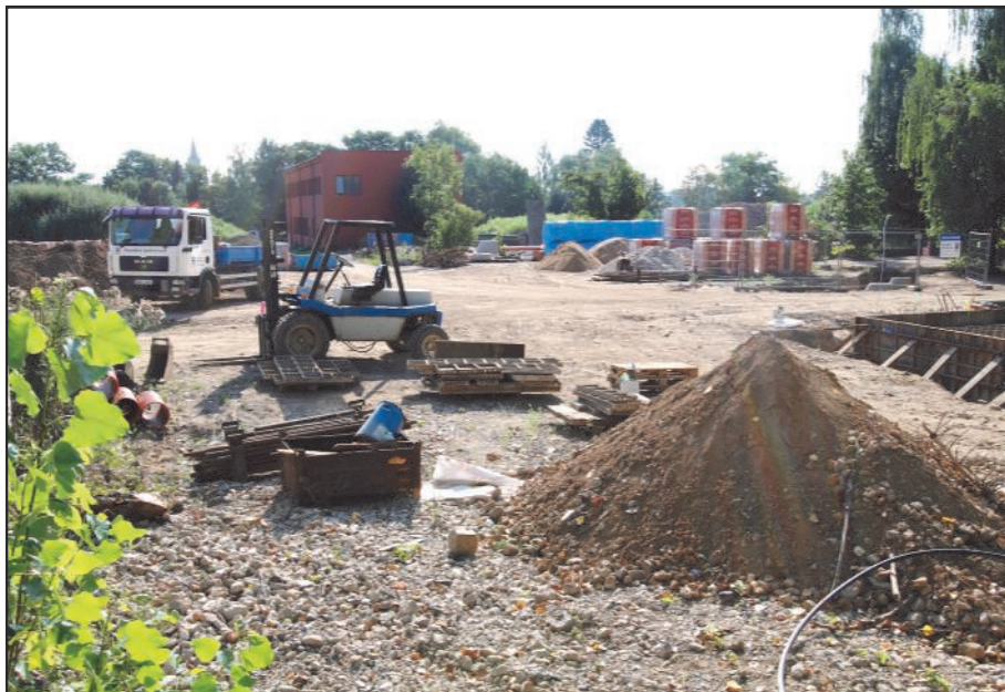
Stavební práce na nové epozici jihozápadní Afriky. (sj)
