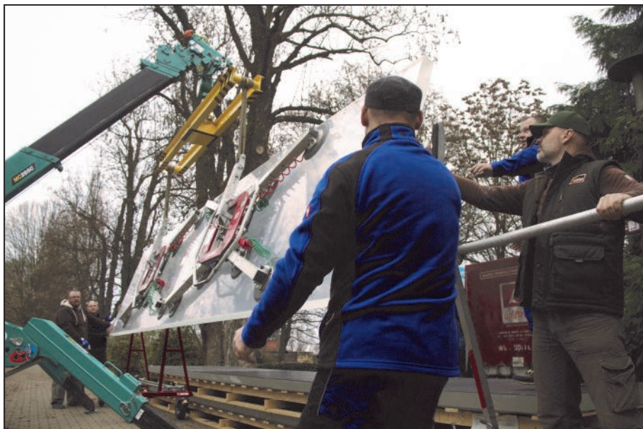
Instalace nových skel do pavilonu Vodní Světy v rámci rekonstrukce v projektu „Z tropů do tropů po česko-polském pomezí“. (sj)
