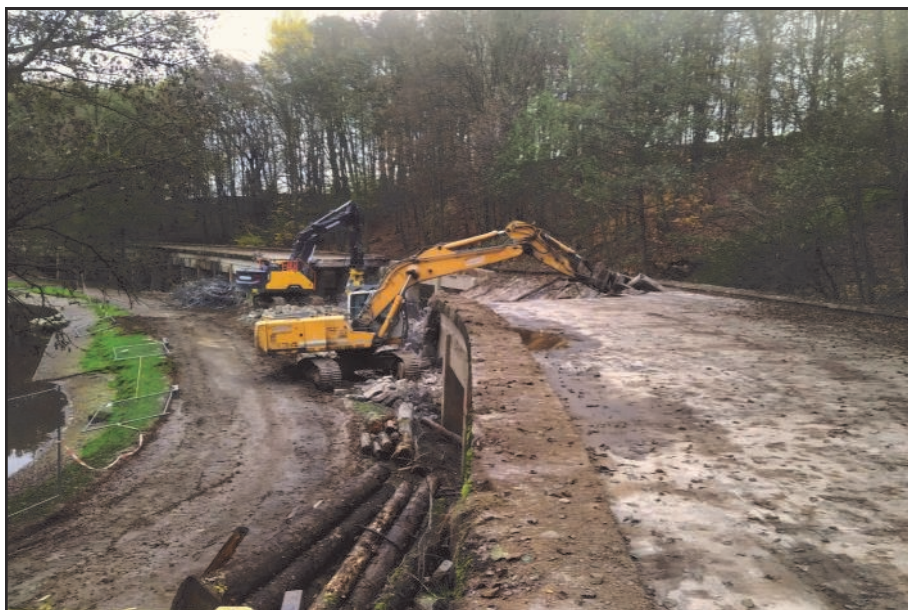
Rekonstrukce mostu M2. (jp)
