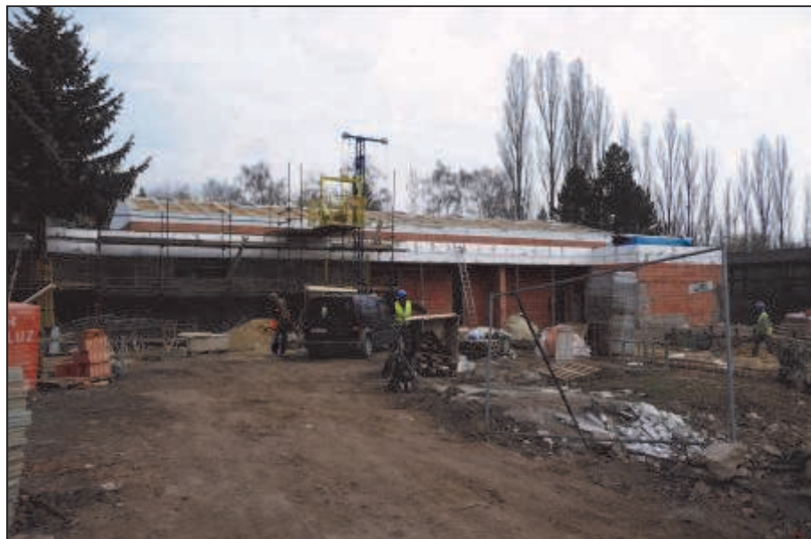
Hrubá stavba pavilonu. (vm)
