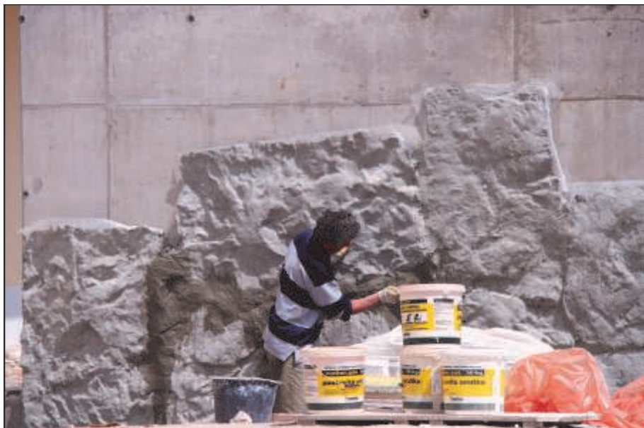
Realizace umělých skal na betonových stěnách výběhu – 30.5.2012. (dh)
