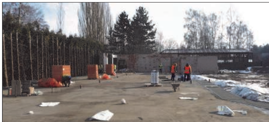
Základová deska pavilonu. (vm)
