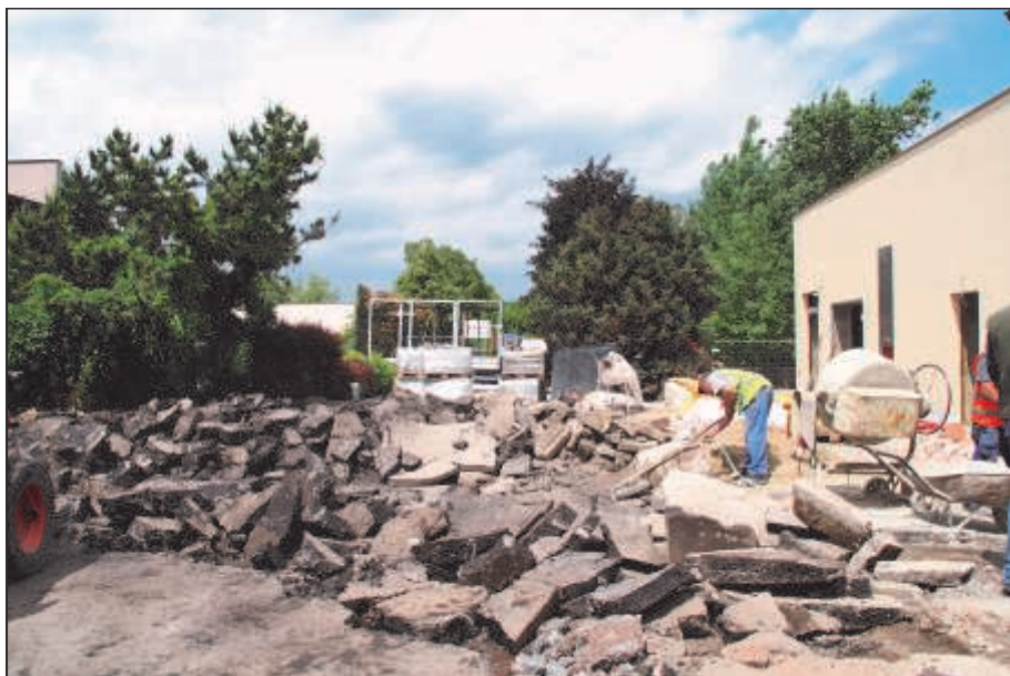
Bourání asfaltových komunikací kolem pavilonu – 30.5.2012. (dh)
