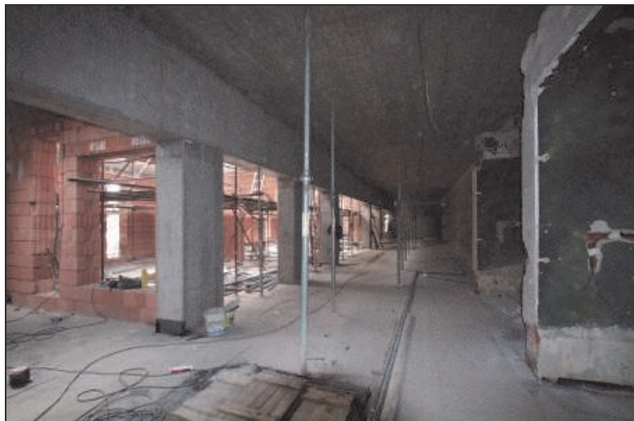
Interiér pavilonu a chodby pro návštěvníky 19.4.2012. (dh)
