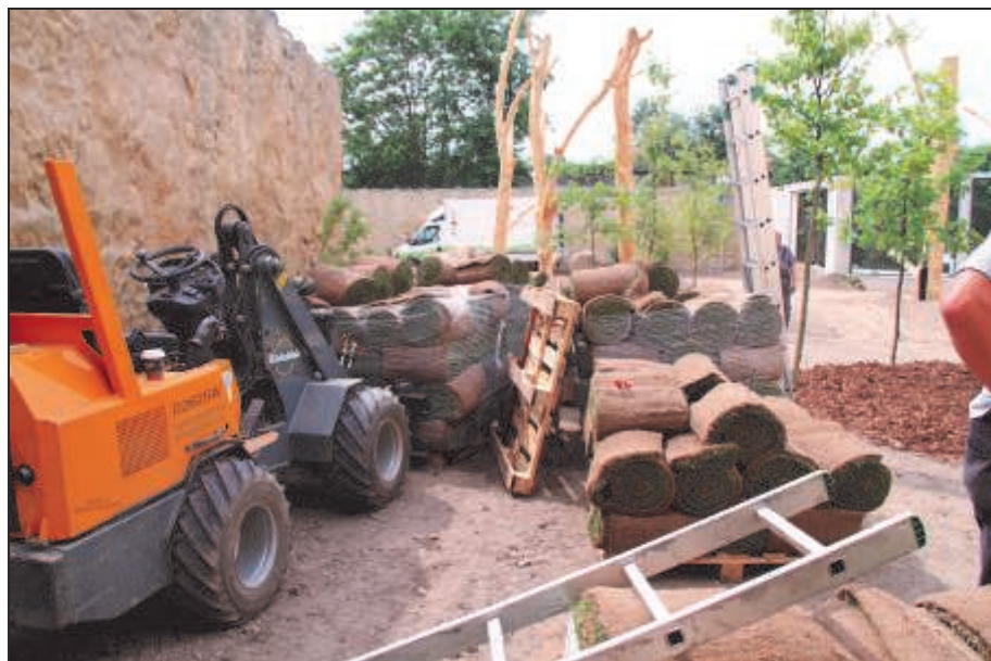
Instalace kobercových trávníků – 19.6.2012. (dh)
