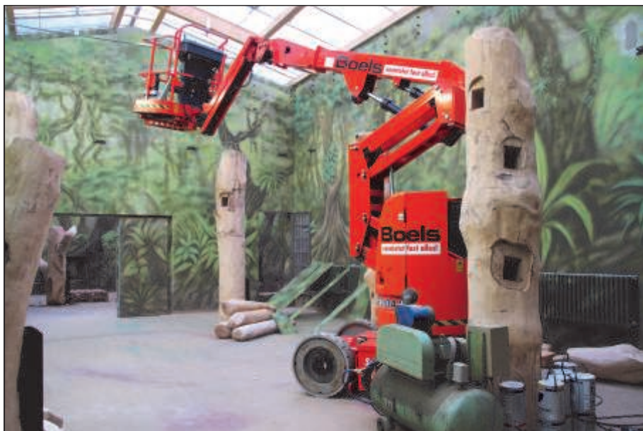
Dokončování detailů stropů v expozicích bylo prováděno z plošiny – 20.6.2012. (dh)
