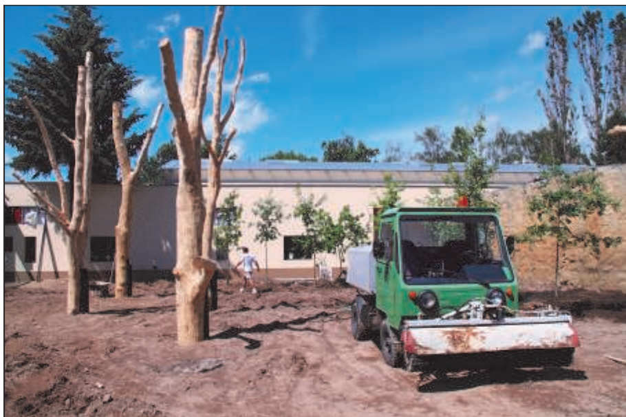
Úprava terénu ve výběhu s novými parkovy a vysazenými stromky – 15.6.2012. (dh)
