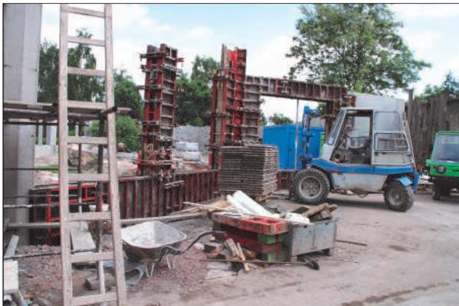
Realizace stěny výběhu – 30.5.2012 (dh).
