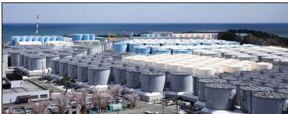
U elektrárny se nachází více než 1000 nádrží s radioaktivní vodou. Zdroj: wikimedia.org
