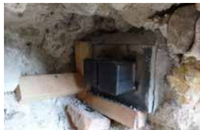
Zavíčkování kotevního bloku
