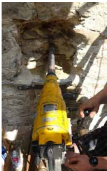
Vrtání jádrového vrtu
