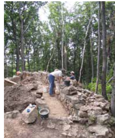
3) hrad Starý Světlov, průběh konzervačních prací na zříceninách hradby jádra (foto autor 2013).
