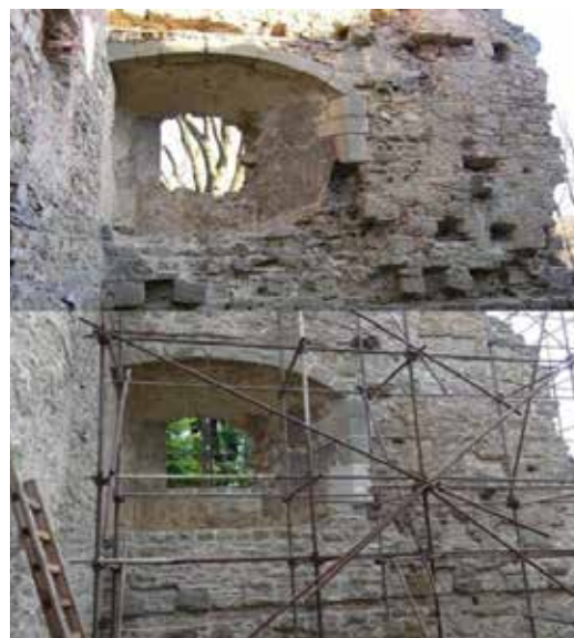
Dopnění špalety okna
