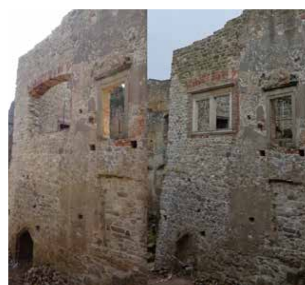
Osazená replika kamenného ostění
