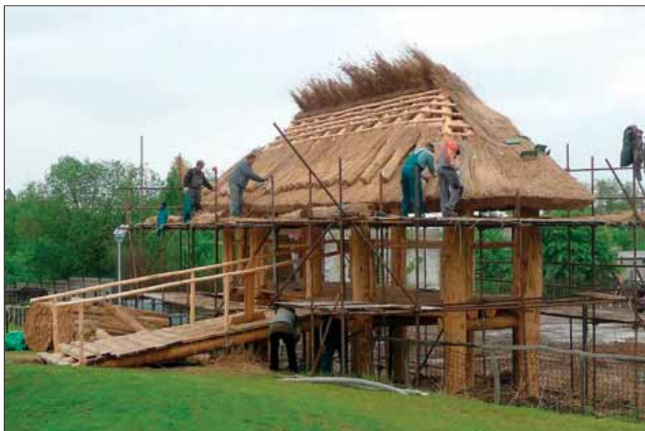
Montáž rákosové krytiny dřevěného vyhlídkového přístřešku ve výběhu u Safarikempu (vm)
