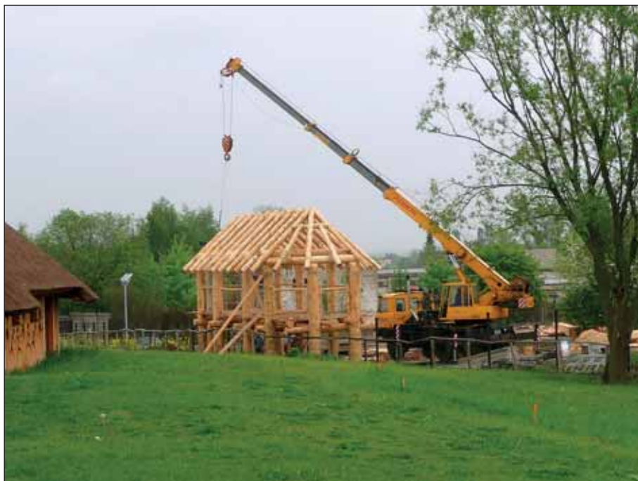
Montáž konstrukce dřevěného vyhlídkového přístřešku u Safarikempu (vm)
