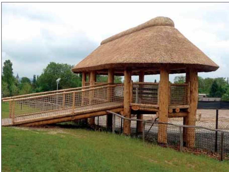
Dokončený dřevěný vyhlídkový přístřešek Safarikempu (vm)
