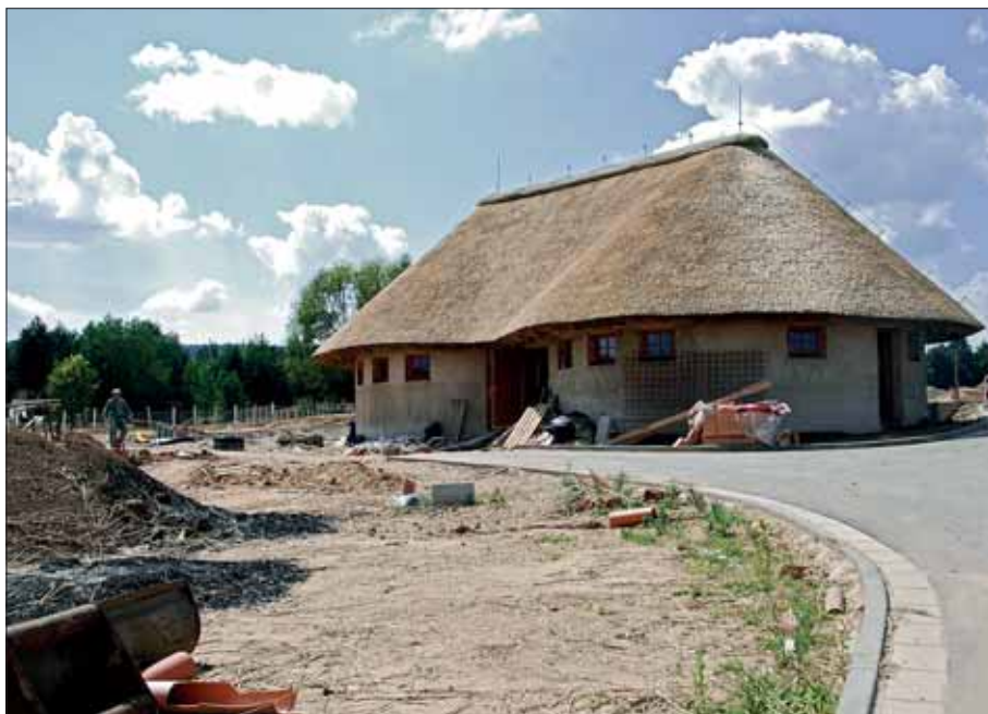
Výstavba objektu hygienického zařízení. (dh)
