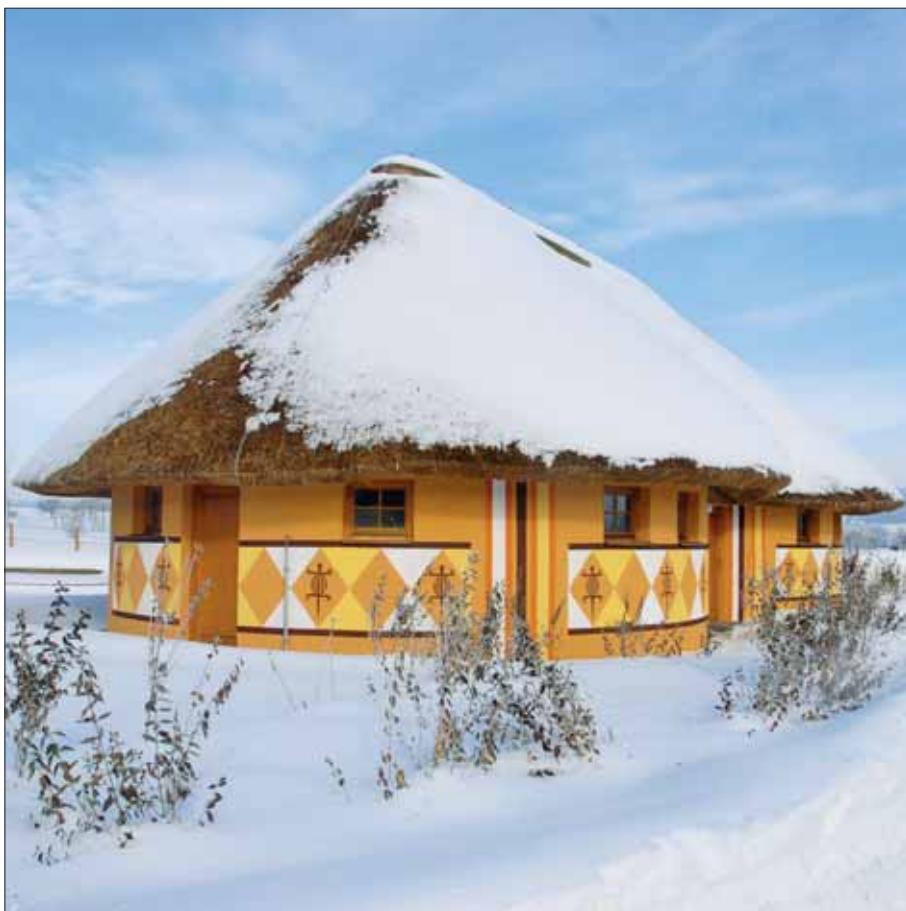
Dokončená budova hygienického zařízení v zimě. (dh)
