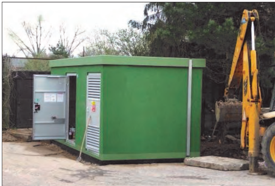
Nová přemístěná trafostanice. (vm)
