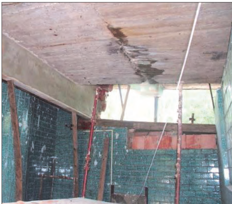
Oprava mostní konstrukce nad chovným zařízením gepardů. (dh)
