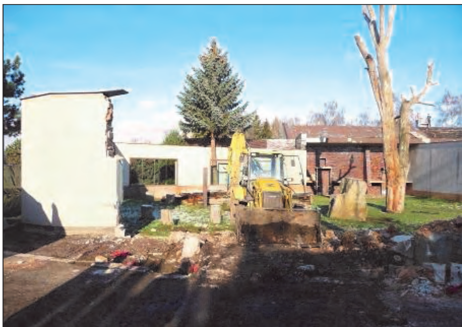
Zahájení prací na přestavbě pavilonu lidoopů na pavilon goril. (vm)
