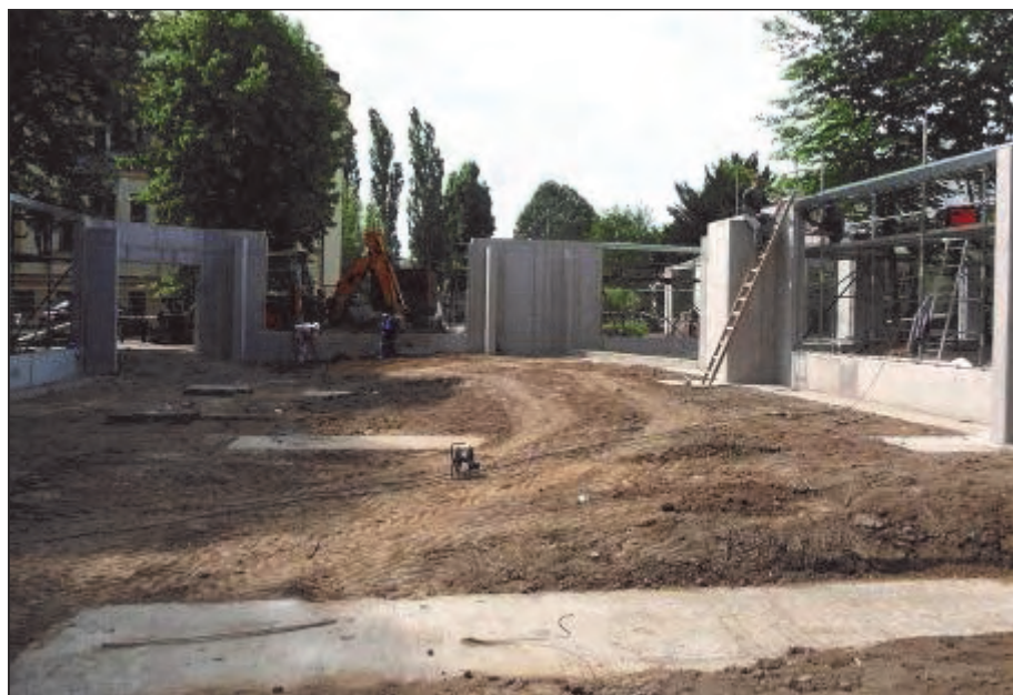
Obvodové konstrukce výběhu pro orangutany II. etapa. (vm)
