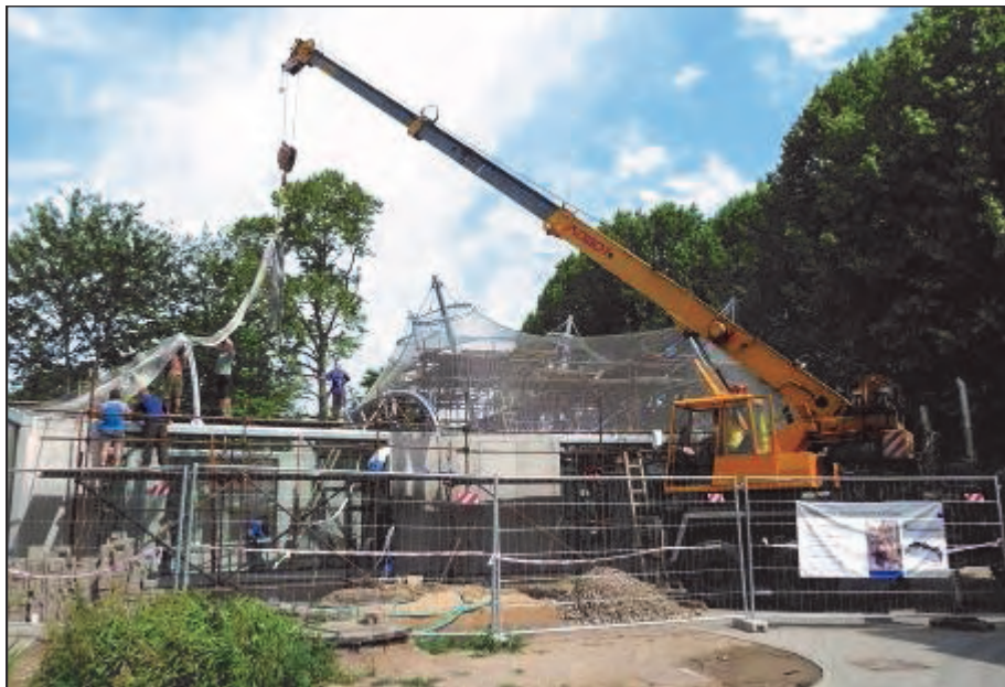
Montáž sítě zastřešení výběhu pro orangutany II.etapa. (vm)
